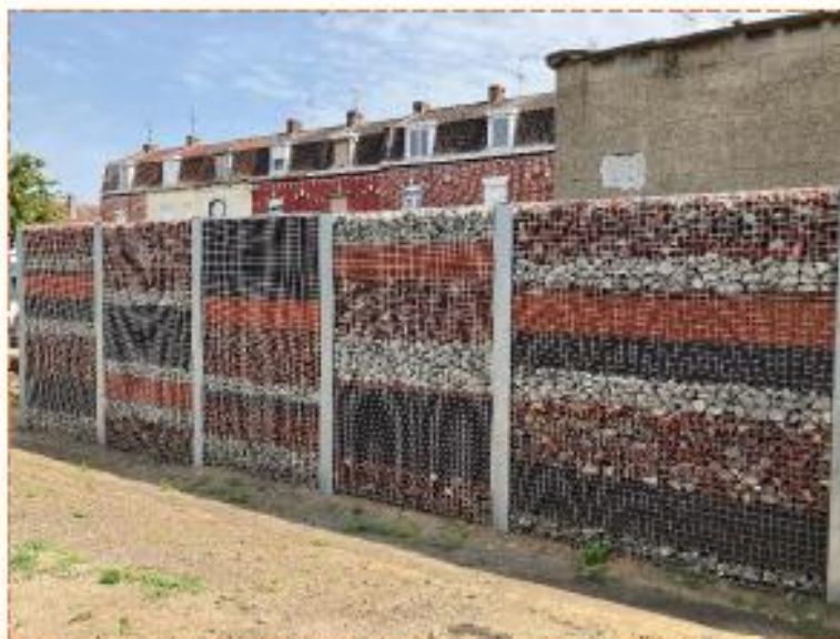
Réalisation d'un mur en gabions à base de matériaux récupérés
