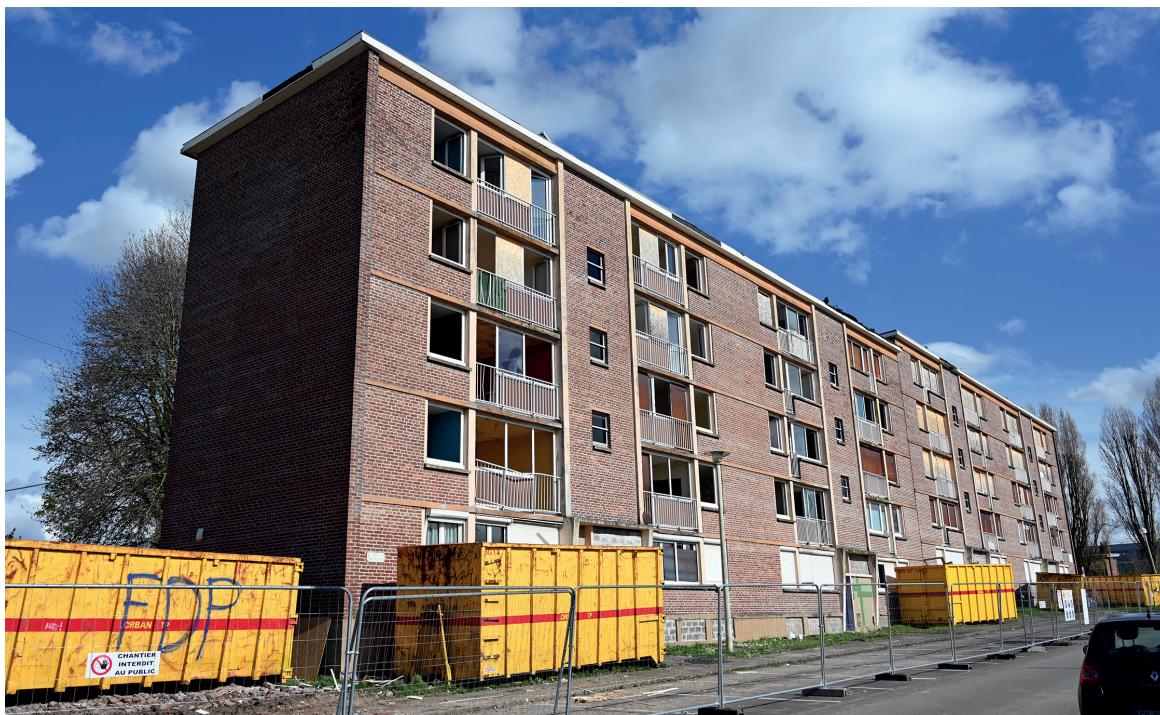
A l'automne, il ne restera plus rien des deux dernières barres des Villas.
