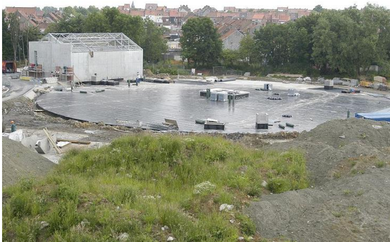
Construction du bassin d'orage du Mont-à-leux
